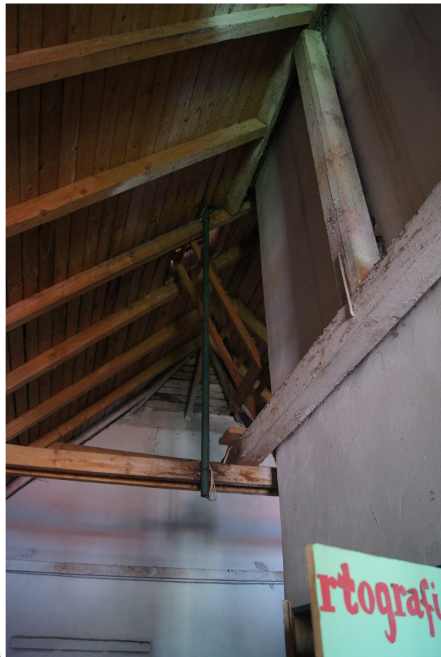
Konstrukcja dachu przy kominie
