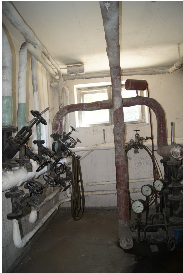
Instalacje w kotłowni
