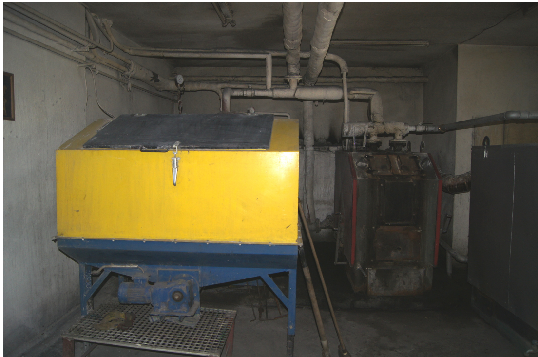
Instalacje w kotłowni oraz piecu.
