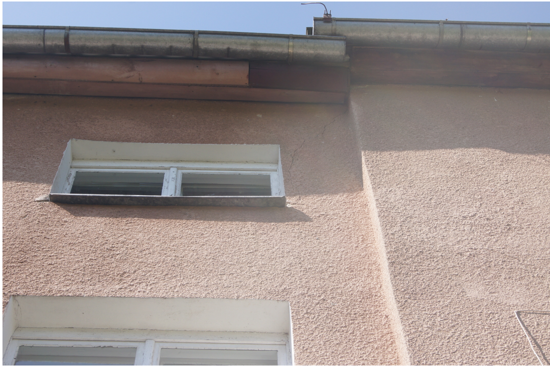
Szczyt elewacji południowej w obrębie uskoku budynku
