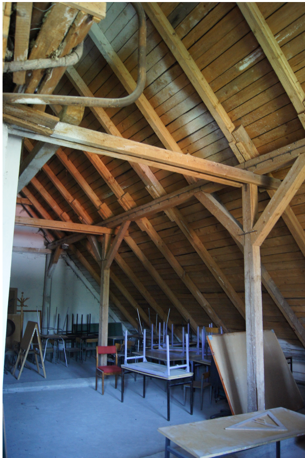
Konstrukcja dachu - z poddasza
