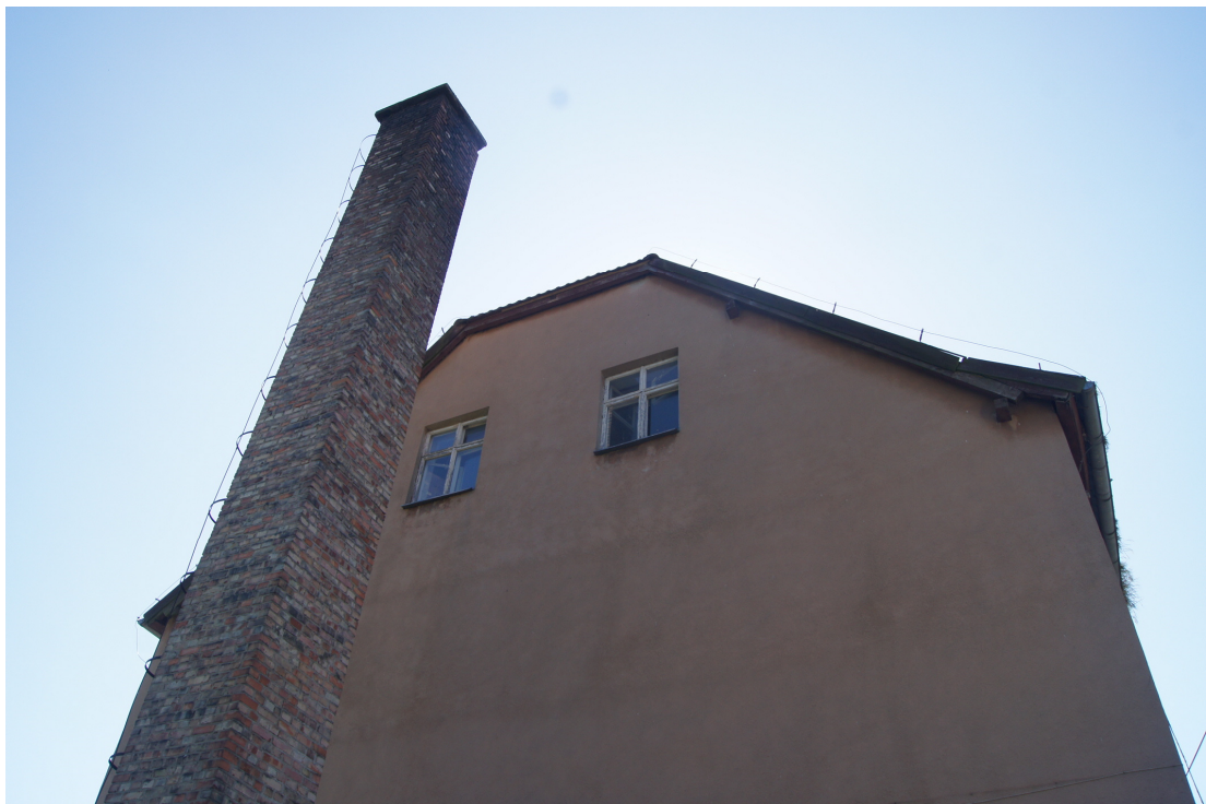
Elewacja wschodnia szczytowa z kominem kotłowni
