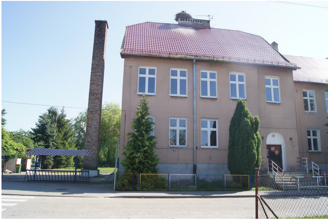
Elewacja północna – widok na komin kotłowni i wejście główne
