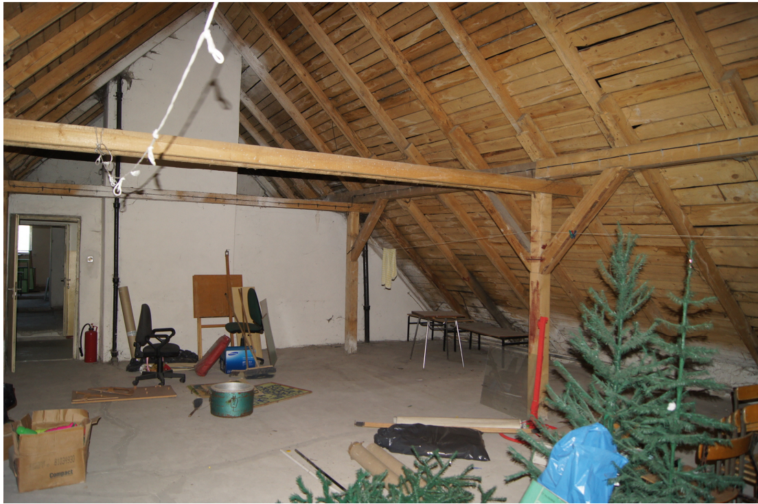
Konstrukcja dachu - z poddasza
