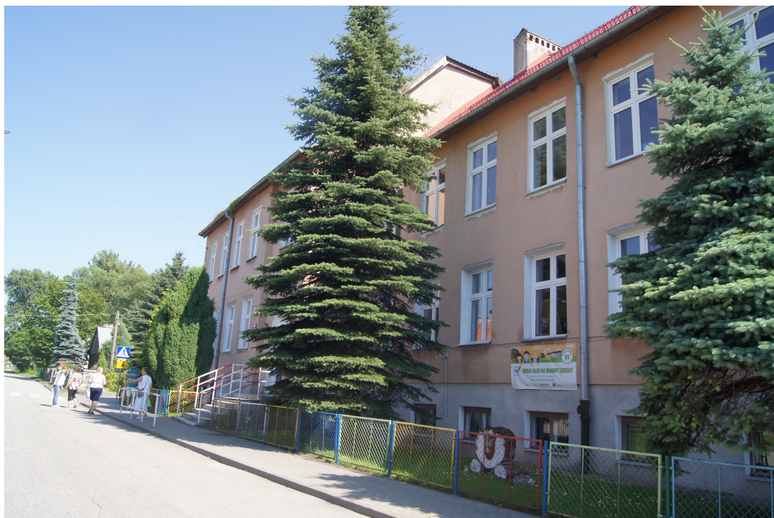
Elewacja północna – widok na część budynku z dotychczasową szkołą
